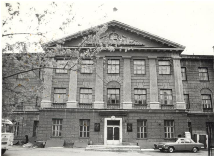
Здание Химико-металлургического института.
